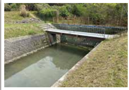
4月24日・25日 山根川（龍野町）と瀬戸川（揖保川町）の 課題を現場確認。土木事務所へ要望。
