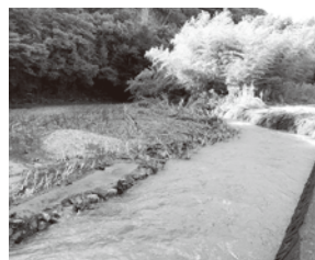
大雨の被害を視察、たつの市内
